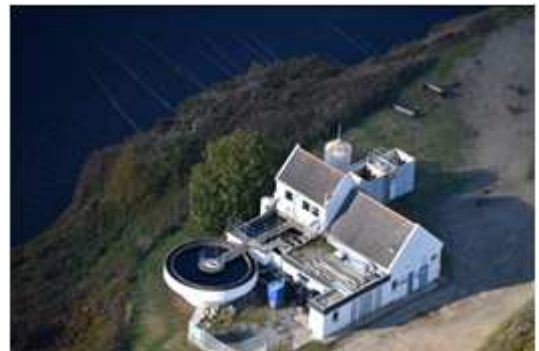
Figure 65 : Station de traitement de Port Melin (Cliché : Géos/AEL)
