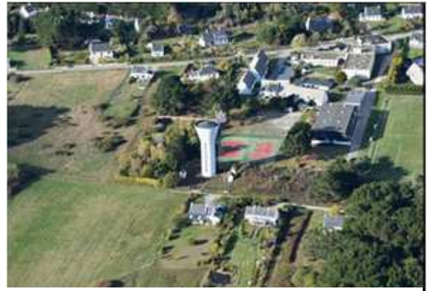
Figure 64 : Château d'eau de Créhal (Cliché : Géos/AEL)
