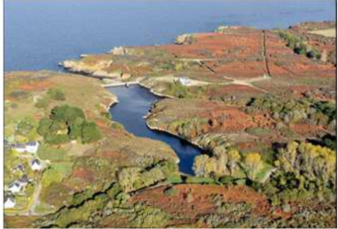
Figure 63 : Le barrage de Port Melin (Cliché : Géos/AEL)
