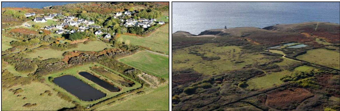
Figure 67 : Les stations d'épuration par lagunage de Quelhuit et de Kerlard (Clichés : Géos/AEL)
