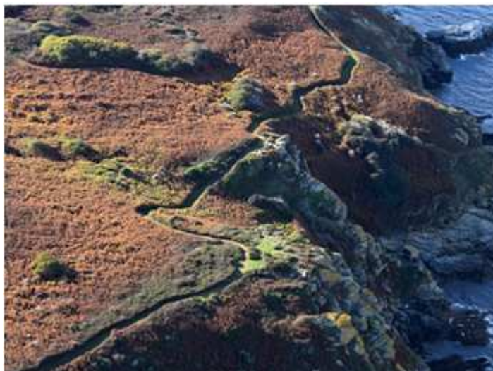
Figure 57 : Le sentier côtier au niveau du Fort du Grognon (Crédit photo : Géos/AEL)
